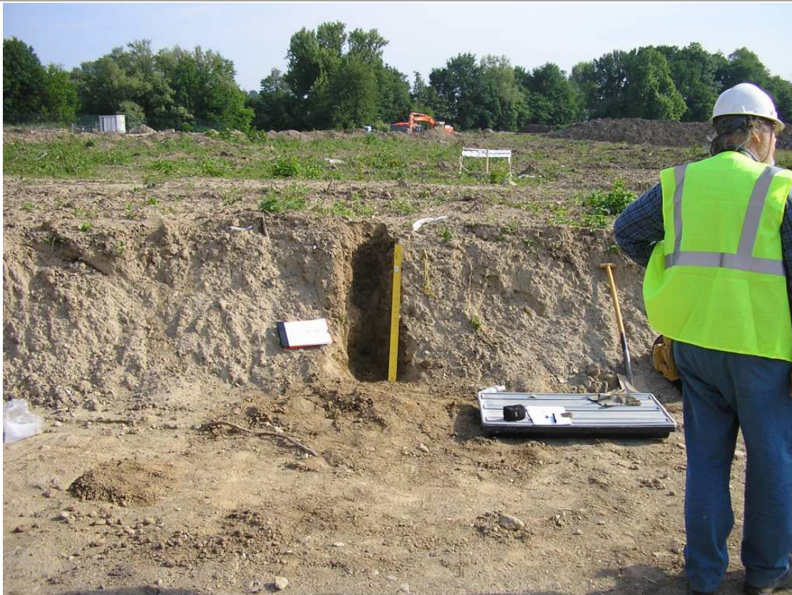
FOTO 2 Operazioni di rilievo
