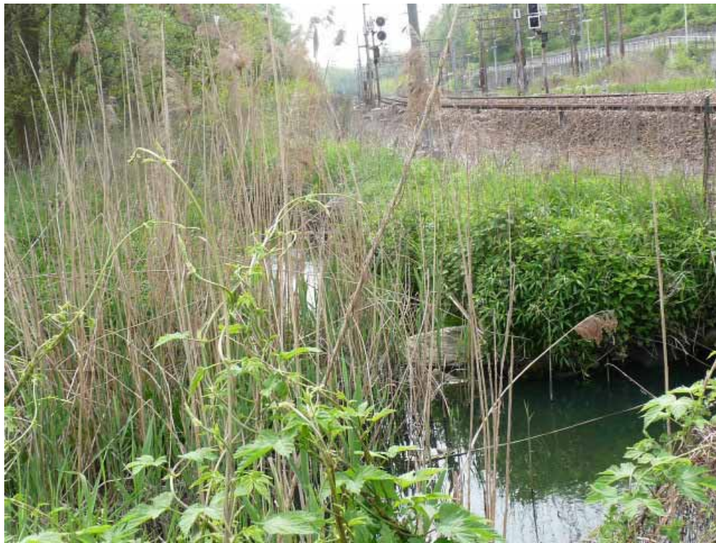
FOTO 1 Canale lungo la ferrovia - 2010
