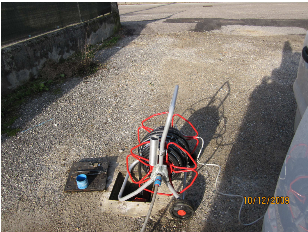
FOTO 2 Vista da est del piezometro.
