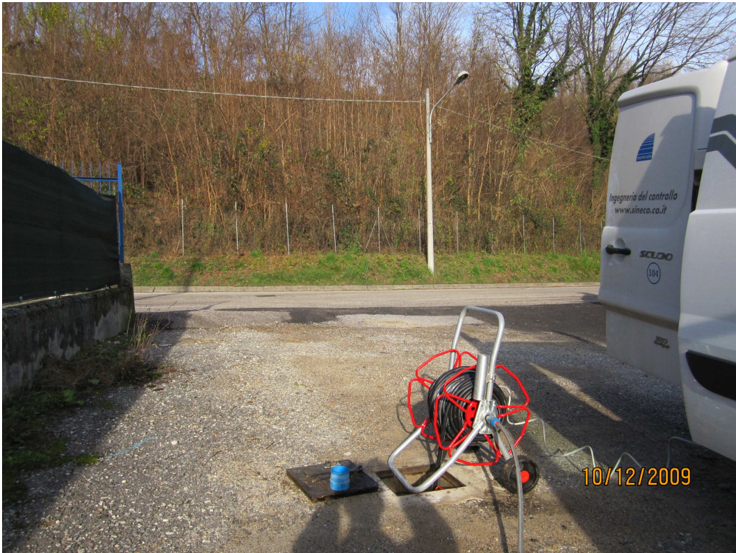
FOTO 1 Vista da sud est del piezometro.
