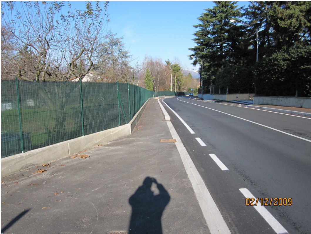
FOTO 1 Vista da sud del piezometro.
