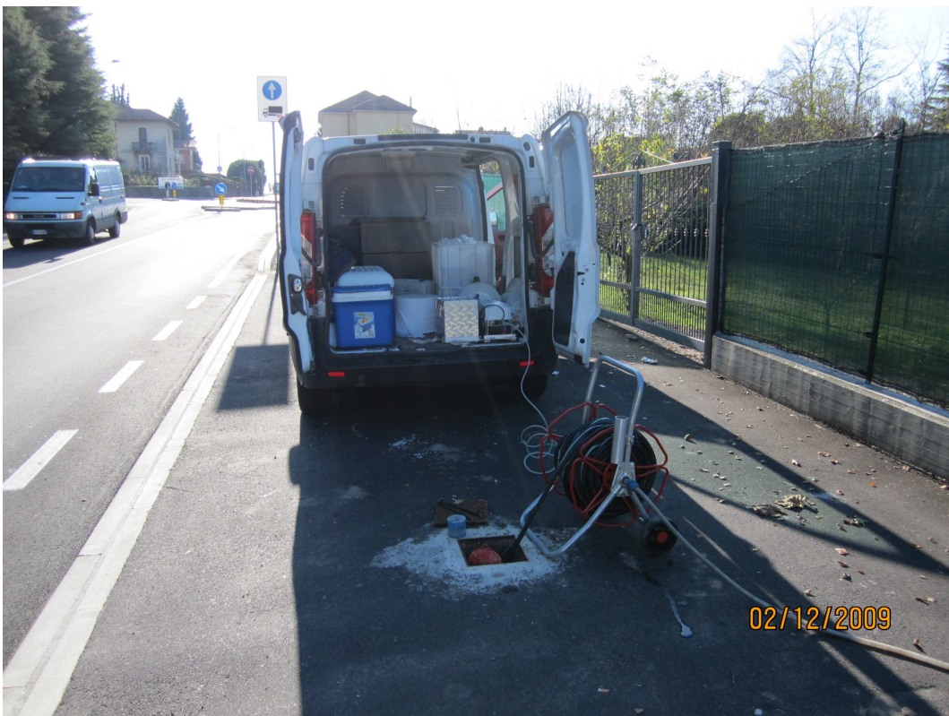
FOTO 2 Vista da nord del piezometro.
