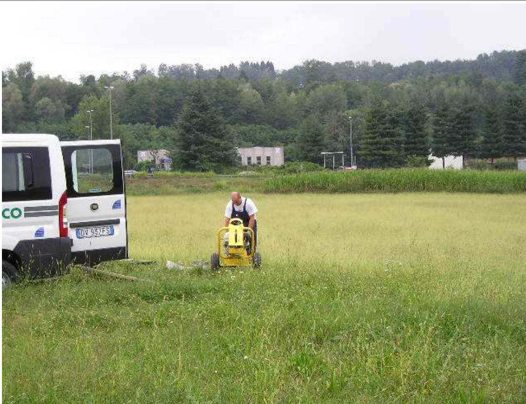
FOTO 2 Dettaglio delle operazioni di rilievo- vista da sud-est su rotatoria tra SP57 e SP 42
