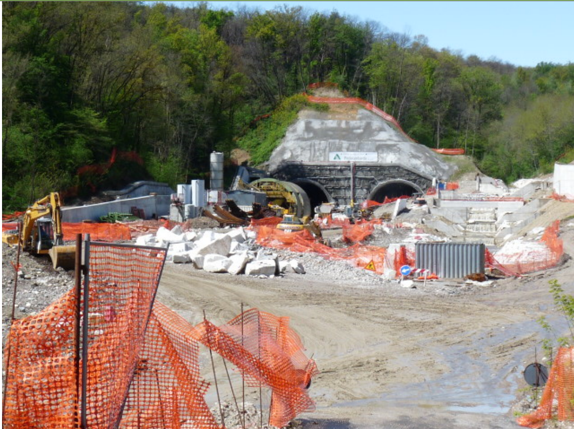
Foto 1 Foto attività di rilievo
