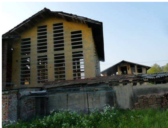
Fig. 6.9/A – Cascina abbandonata della località Fontanelle (stazione VEG-VO-01)
