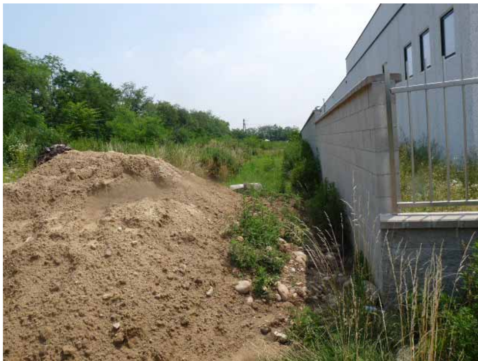
FOTO 1 Stato dell'area dove sorgerà il cantiere - 2009
