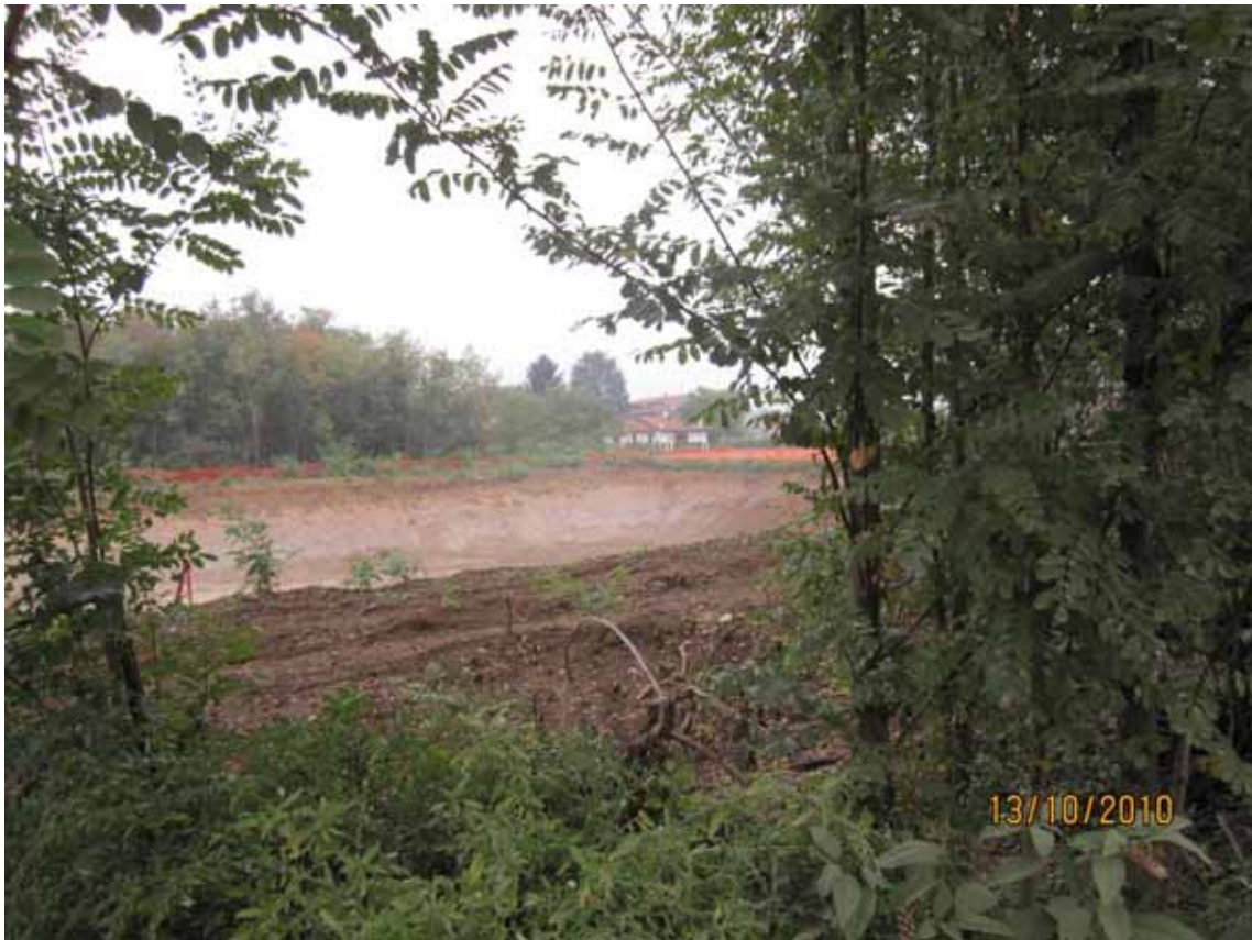
FOTO 1 Vista scavo trincea attraverso il robinieto monitorato - 2010
