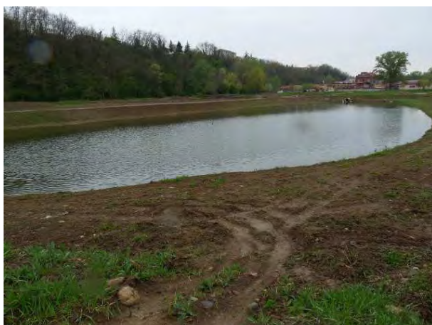
Fig. 6.5/B – nuova cassa di espansione presso la stazione VEG-SO-04 (foto I. Di Già- 13 aprile 2012)
