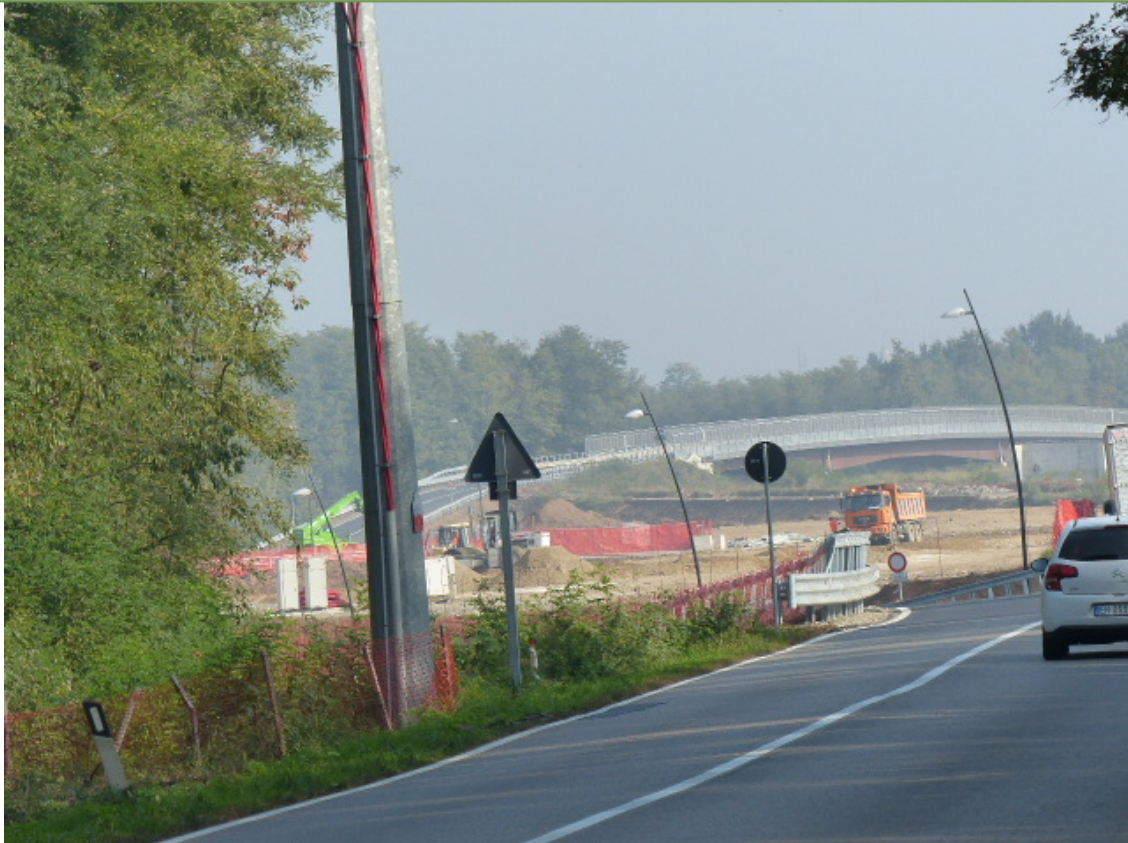
Foto 1 Foto attività di rilievo
