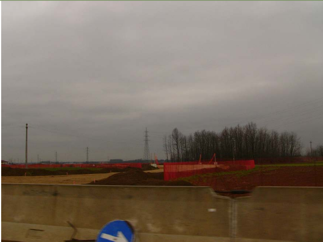
Foto 1 Foto attività di rilievo
