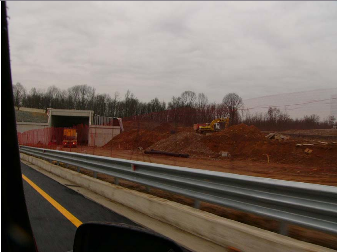
Foto 1 Foto attività di rilievo
