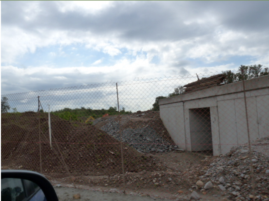
Foto 1 Foto attività di rilievo
