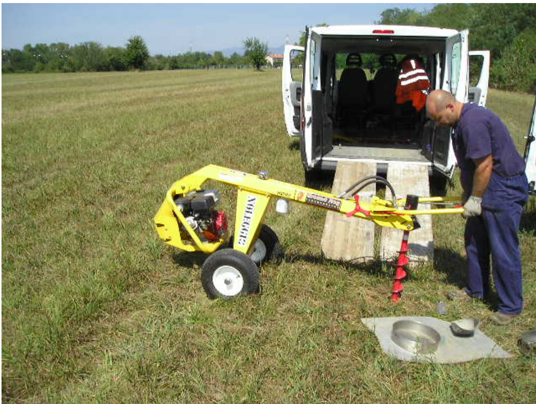
FOTO 2 Vista in direzione nord del punto di monitoraggio
