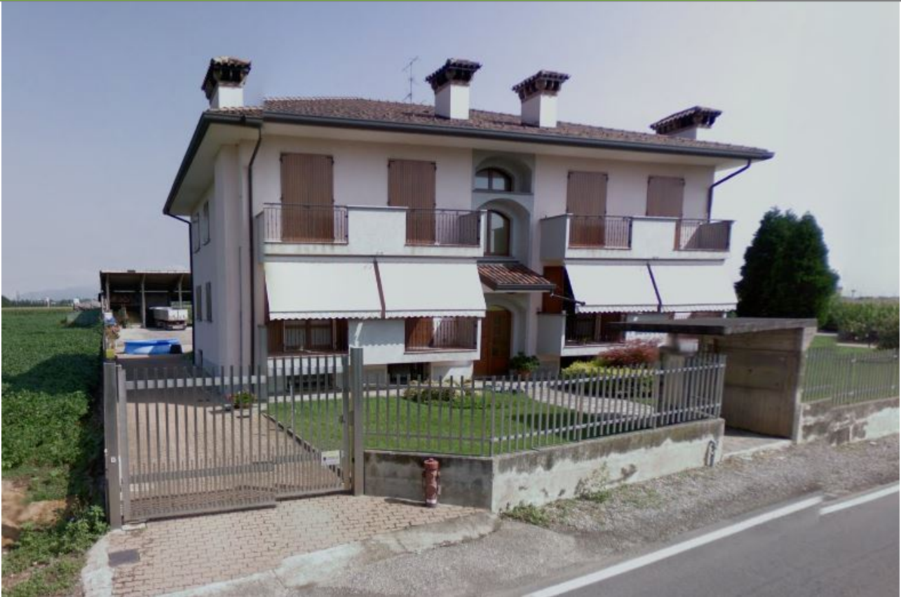
Foto 1 Foto attività di rilievo
