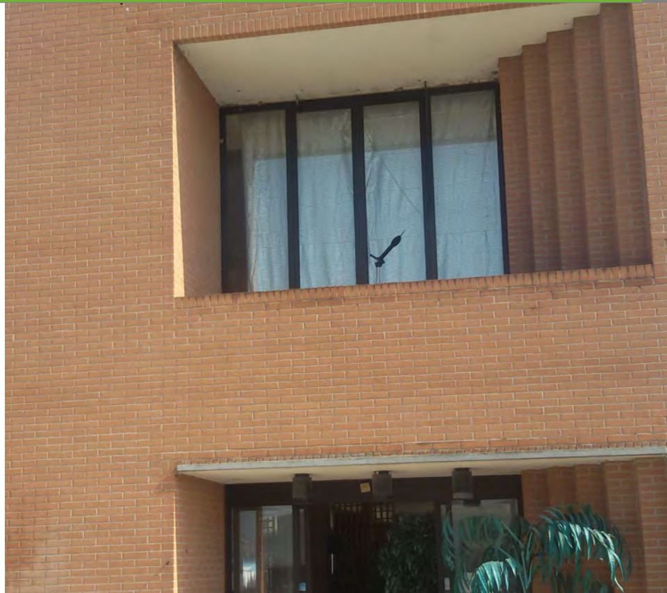
Foto 1 Foto attività di rilievo: fonometro installato
