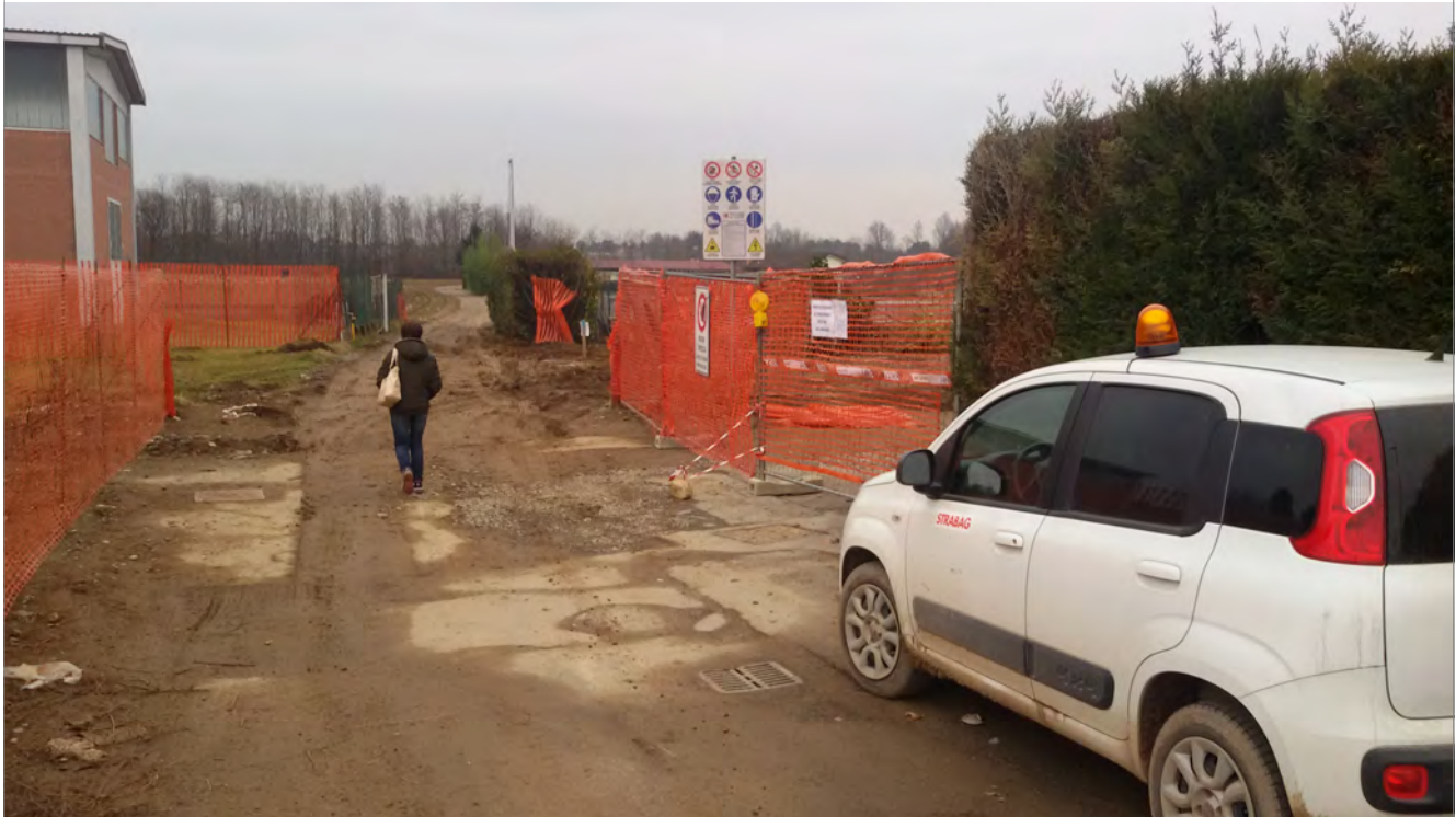
Foto 3 Foto attività di rilievo: cantiere
