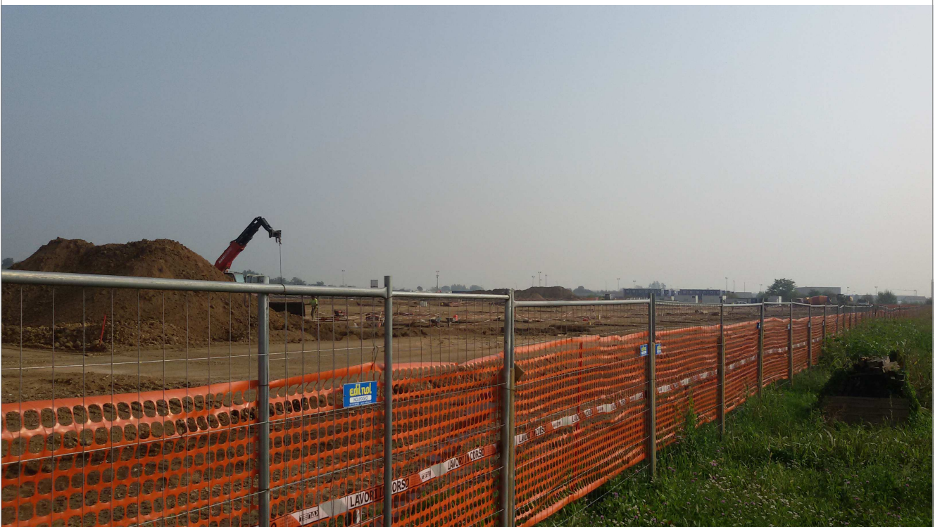
Foto 4 Foto cantiere (estraneo ad APL) denominato "Lottizzazione Consorzio Industriale S. Lorenzo"
