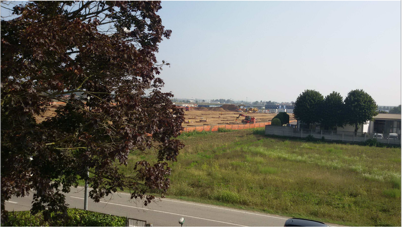
Foto 3 Foto cantiere (estraneo ad APL) denominato "Lottizzazione Consorzio Industriale S. Lorenzo"
