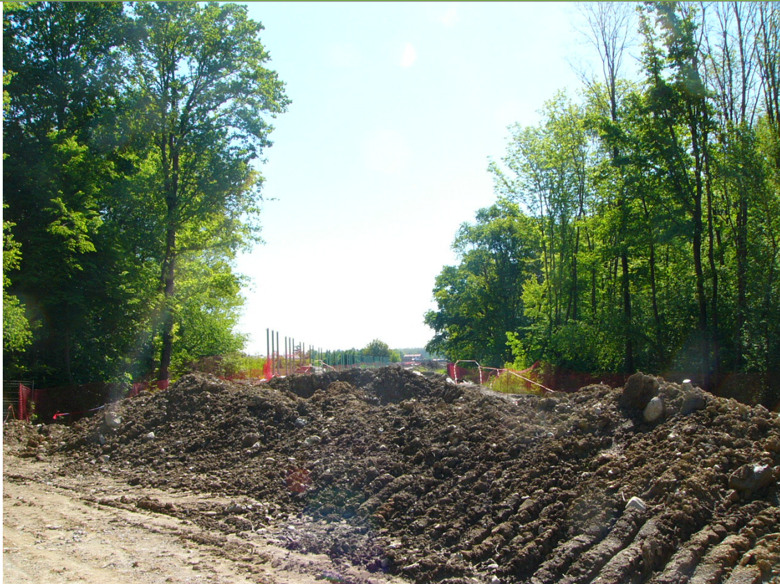
Foto 1 Foto attività di rilievo
