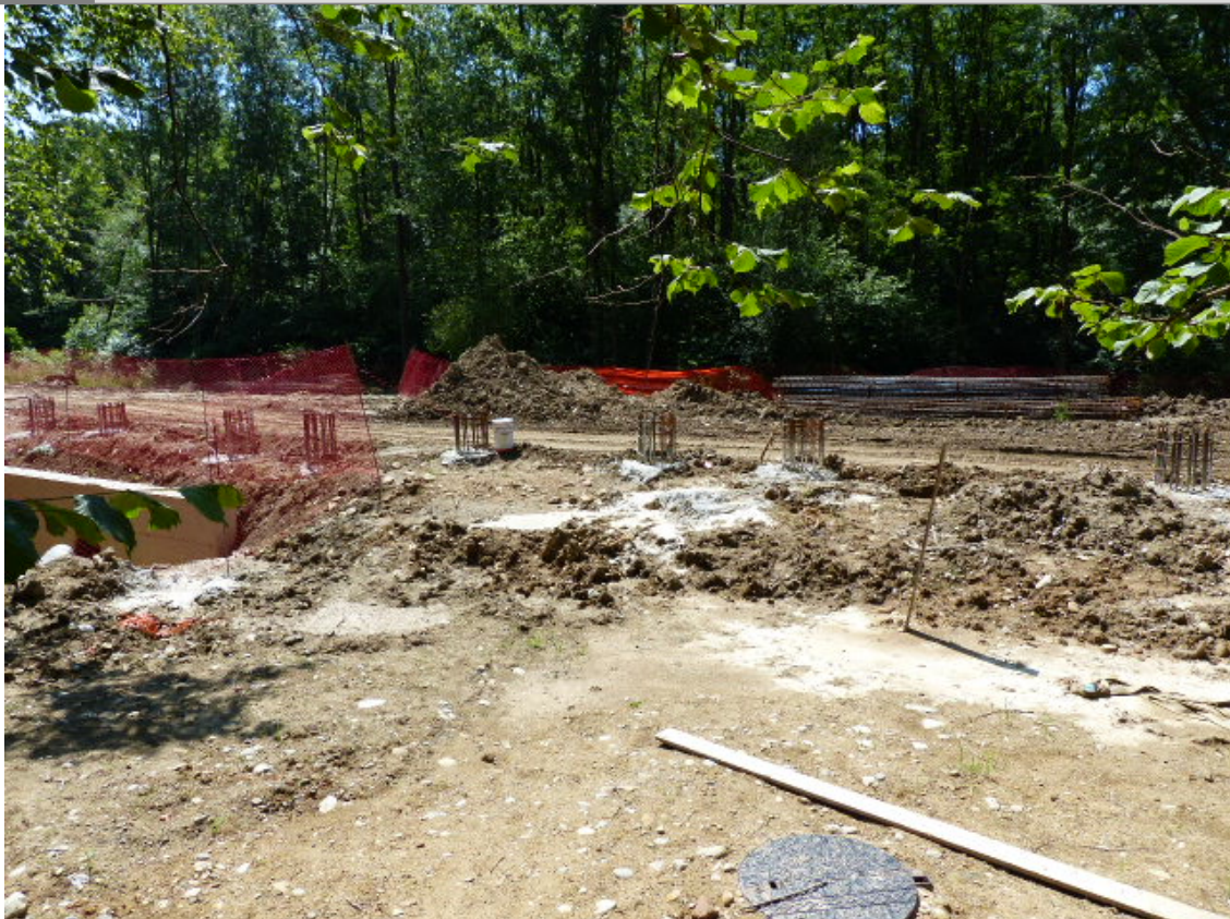
Foto 2 Foto attività di rilievo
