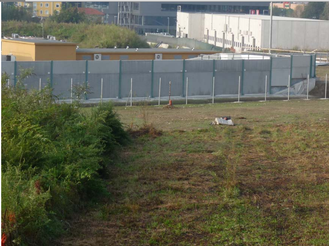
Foto 2 Foto attività di rilievo
