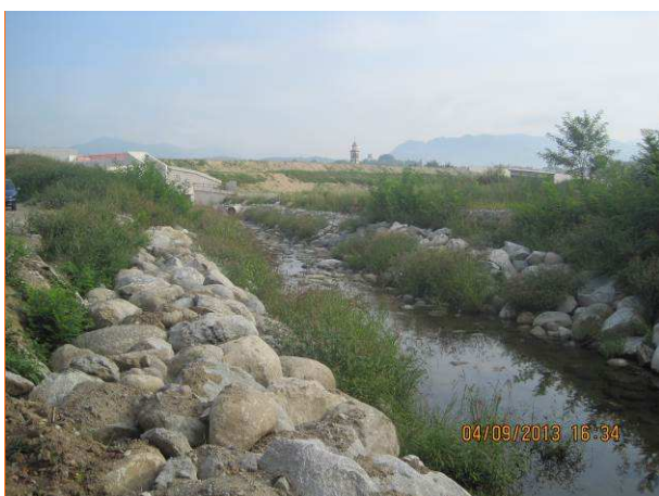
Foto 1: FIV-SE-03 - vista verso monte: risistemazione idraulica fiume Seveso
